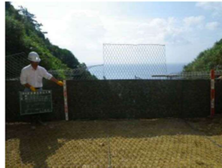
写真 4-2 吸出し防止材設置状況 (沖縄施工)
