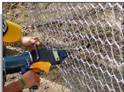
図 4-7 レーシングワイヤー及び C リング結束位置
