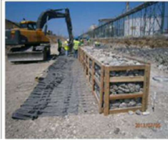
木材を用いた例 (トルコ施工事例)
