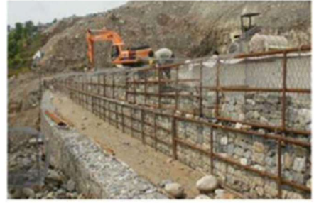
鋼材を用いた例 (インド施工事例)
