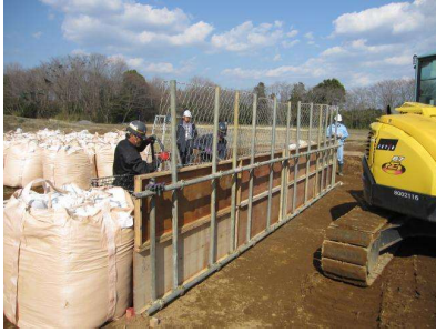
単管パイプとコンパネを用いた例 (土木研究所施工例)
