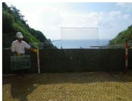
図 4-10 吸出し防止材配置状況図
