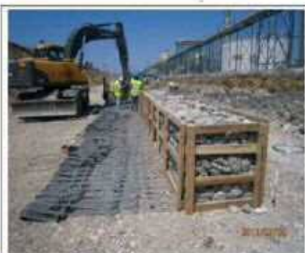
木材を用いた例 (トルコ施工事例)
