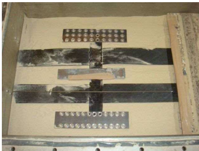
図 2-4 引抜き試験状況写真（敷設後）
