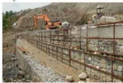
鋼材を用いた例 (インド施工事例)
