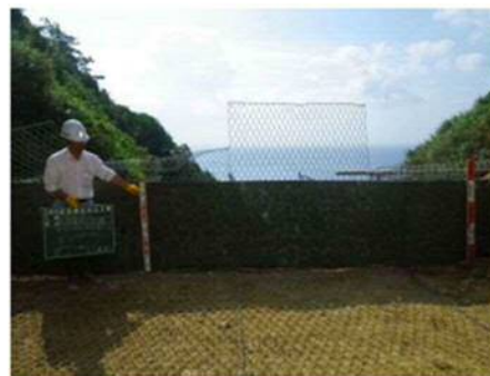
写真 4-2 吸出し防止材設置状況 (沖縄施工)
