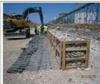
木材を用いた例 (トルコ施工事例)
