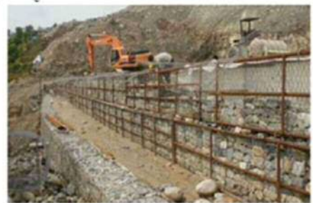
鋼材を用いた例 (インド施工事例)
