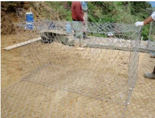
④ 仕切りパネルを中央部に設置する。
