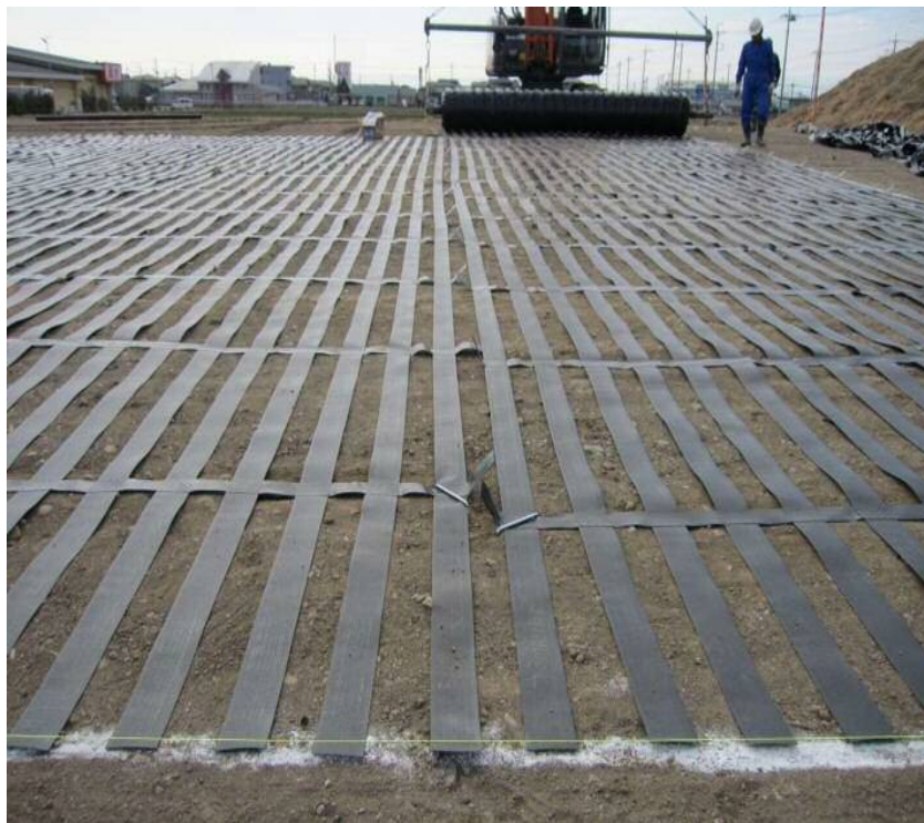
写真⑪ 隣り合うパラリンク（突合せ）
