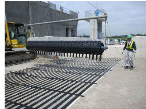
吊り冶具施工時
