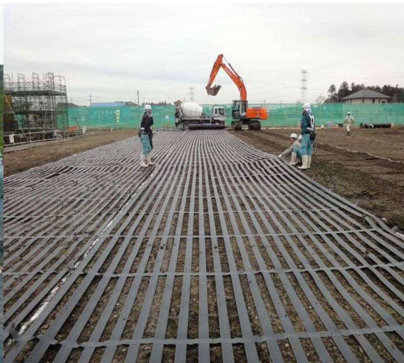
写真⑧ 手作業による引張調節
