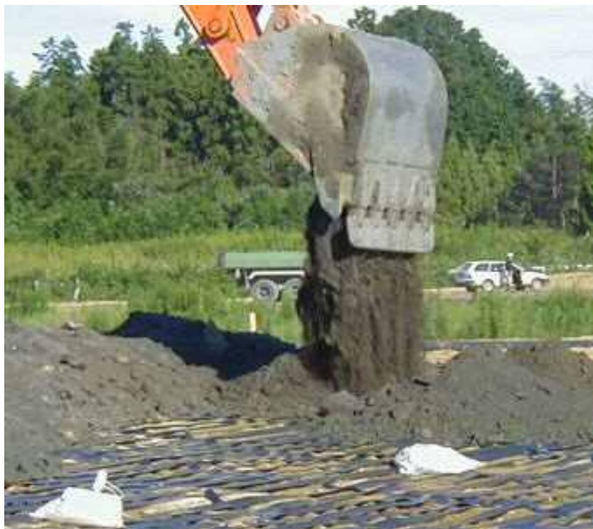
写真⑮ 土の撒き出し
