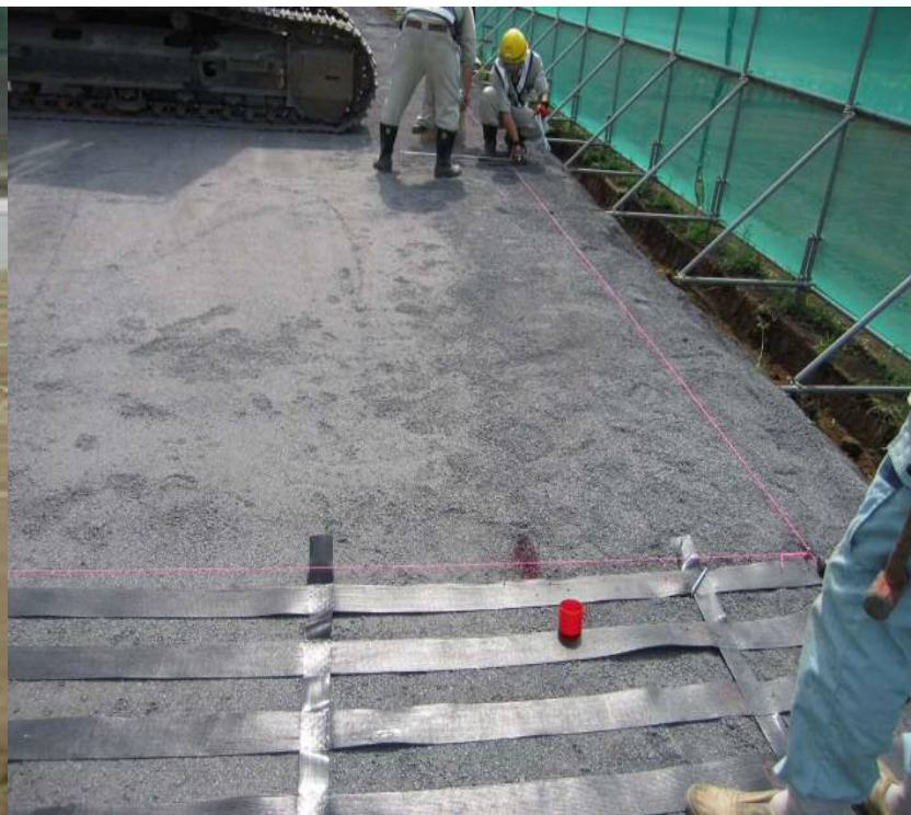
写真④ 水系による割付
