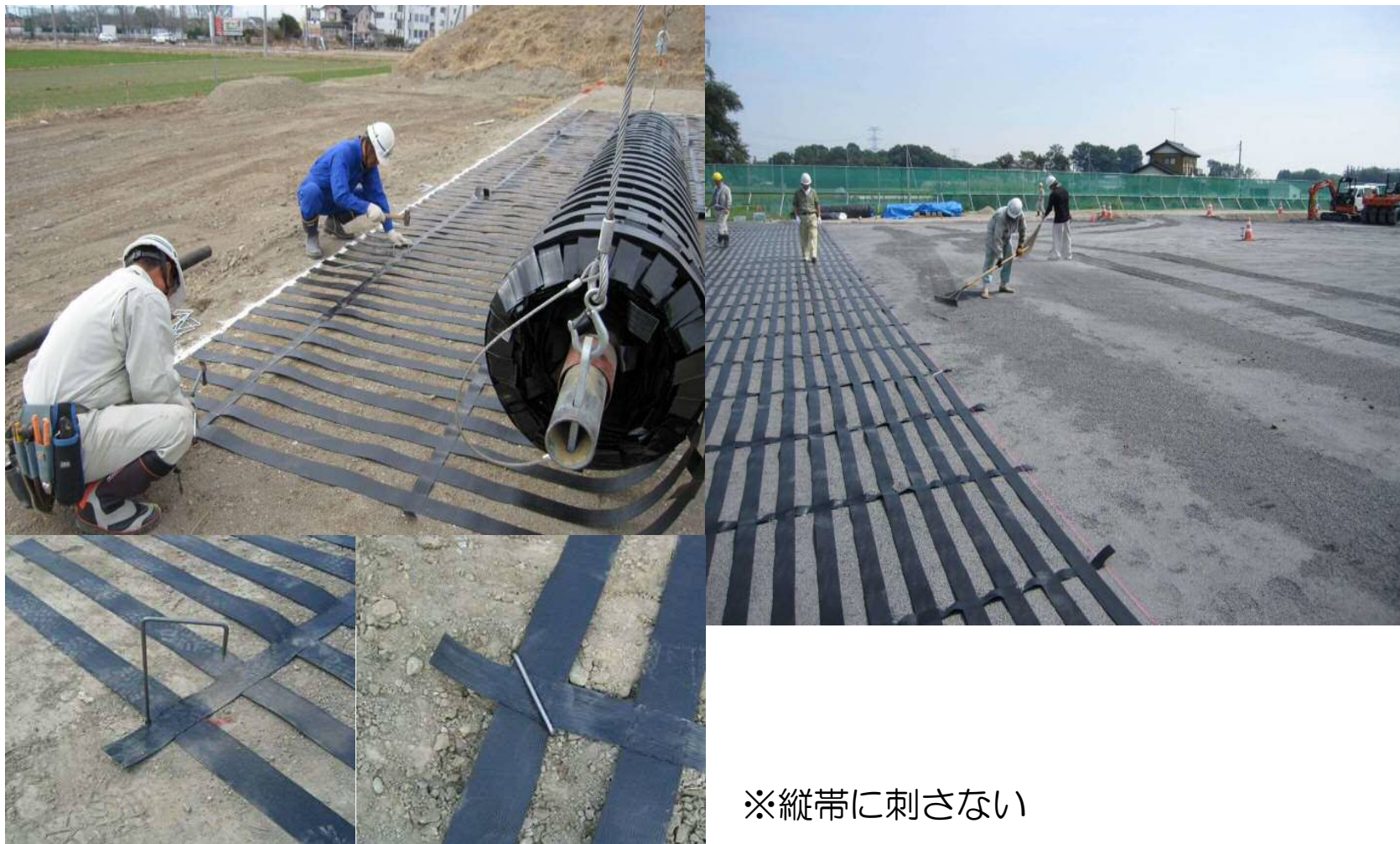
写真⑤ 端部3ヶ所をパラピンにて固
