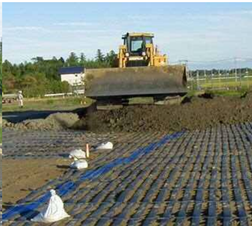
写真⑯ 敷均し、締固め
