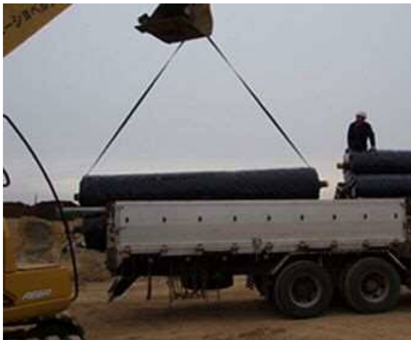
写真① 荷下ろし
