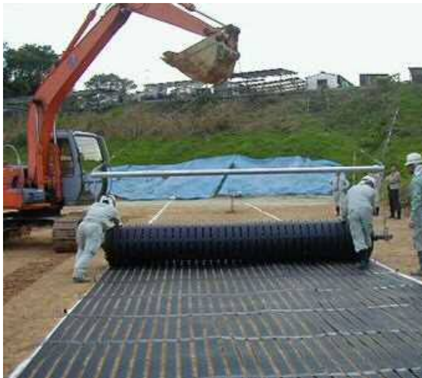
写真⑦ 敷設
