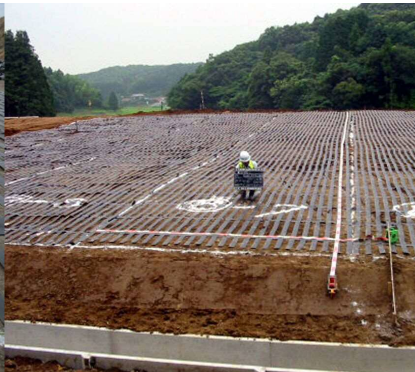
写真⑫ 敷設完了
