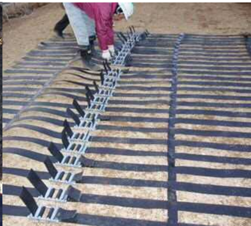
写真⑭ 接続後、手作業による引張調節
