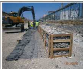
木材を用いた例 (トルコ施工事例)
