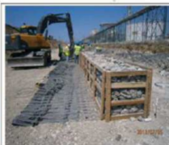
木材を用いた例 (トルコ施工事例)
