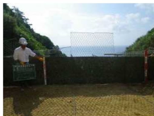
図 4-10 吸出し防止材配置状況図
