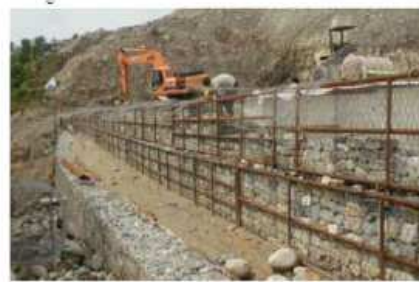
鋼材を用いた例 (インド施工事例)
