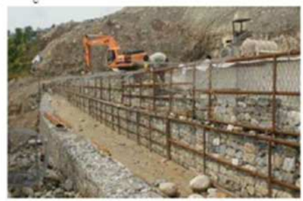
鋼材を用いた例 (インド施工事例)
