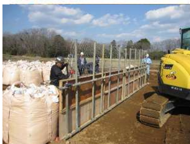
単管パイプとコンパネを用いた例 (土木研究所施工例)
