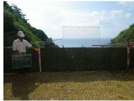
写真 4-2 吸出し防止材設置状況（沖縄施工）
