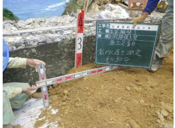
図 3-14 網部中詰材の撒き出し
