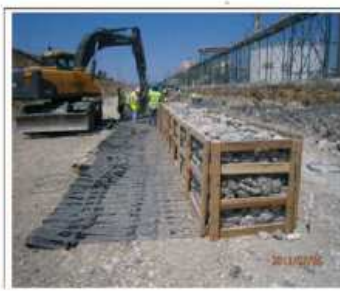
木材を用いた例 (トルコ施工事例)
