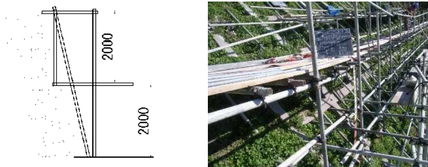
図 3-18 足場工の設置状況
