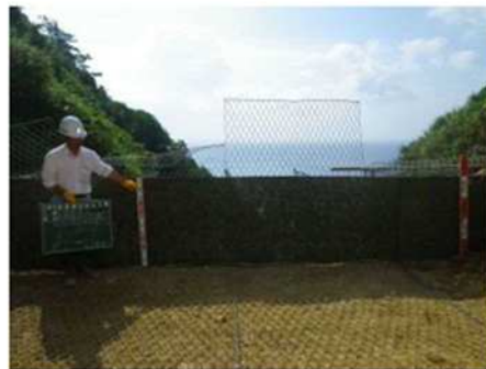
図 3-4 吸出し防止材設置状況（沖縄施工）
