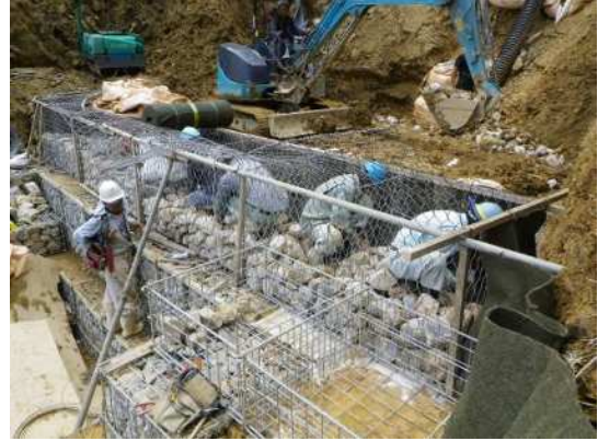
栗石充填手順 (高さ 0.84m,1.0m⇒3 段, 高さ 0.51m⇒2 段)
