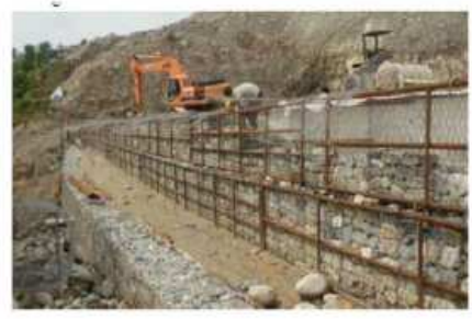
鋼材を用いた例 (インド施工事例)
