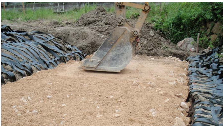
「マットレス工法」の擁壁基礎への適用例
