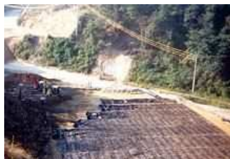
JH 第二名神高速自動車道 平尾工事 2
