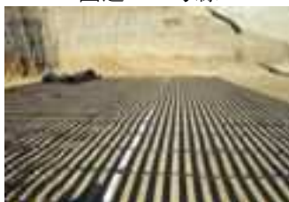
三重県 桑名造成工事
