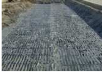
国交省福岡(有明) 208号昭和開 3-2 工区
