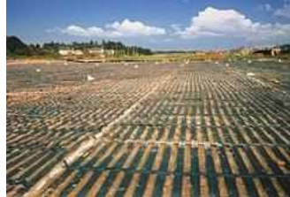
JH 常磐自動車道 つくば JCT 工事
