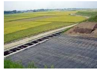
JH 日本海沿岸東北自動車道 豊栄インターチェンジ工事
