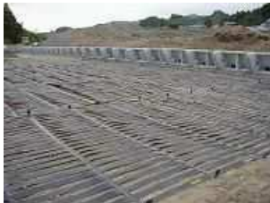
JH 第二東名高速自動車道 森掛川インターチェンジ工事
