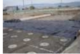
国交省福岡(有明) 208号神田開地区改良工事
