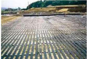
JH 館山自動車道 君津 IC 工事
