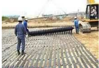
JH 東北縦貫自動車道 荒川工事
