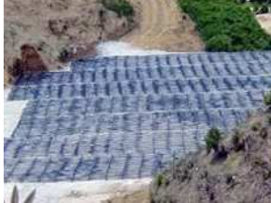
JH 第二名神高速自動車道 平尾工事 1
