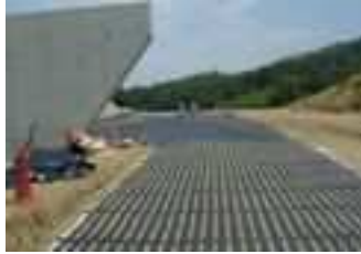
日本道路公団 圏央道木更津 JCT 工事
