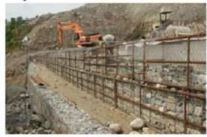
鋼材を用いた例 (インド施工事例)
