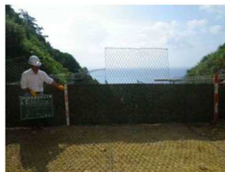
図 3-4 吸出し防止材設置状況（沖縄施工）
