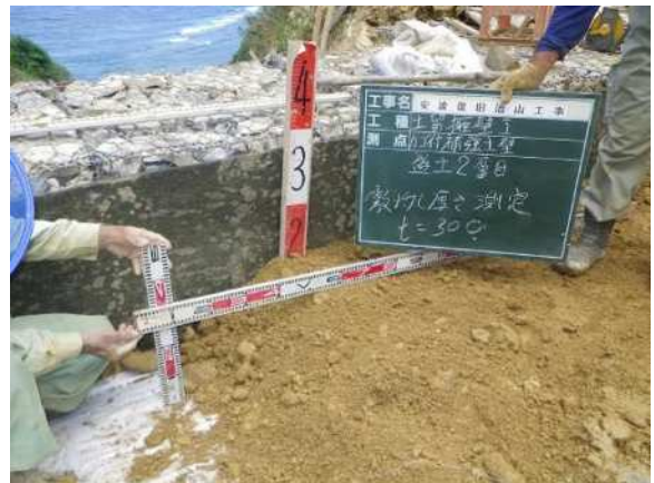
図 3-14 網部中詰材の撒き出し
