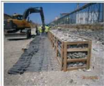
木材を用いた例 (トルコ施工事例)
